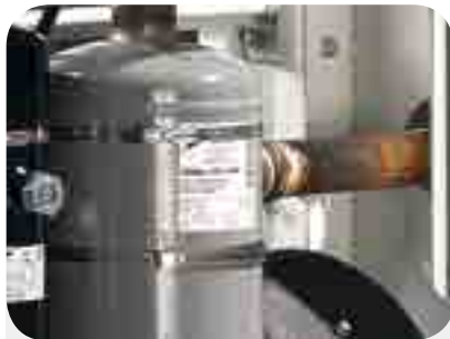
Separatore olio. Oil separator. Ölabscheider. Séparateur d'huile. Separador de aceite. Сепаратор масла.
